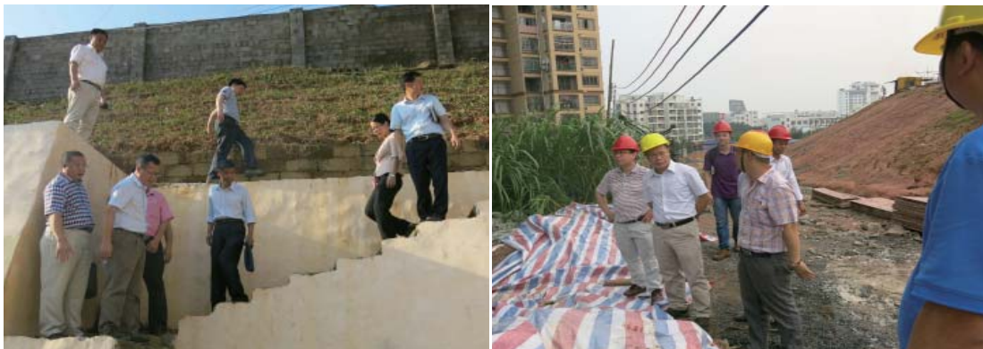
5-6月，自治区国土资源厅副厅长、厅党组成员吴锡熹带队到梧州市、贺州市、桂林市、柳州市督查地质灾害防治工作，图为贺州市黄洞小学崩塌、桂林市荔浦县中学滑坡治理项目检查现场
